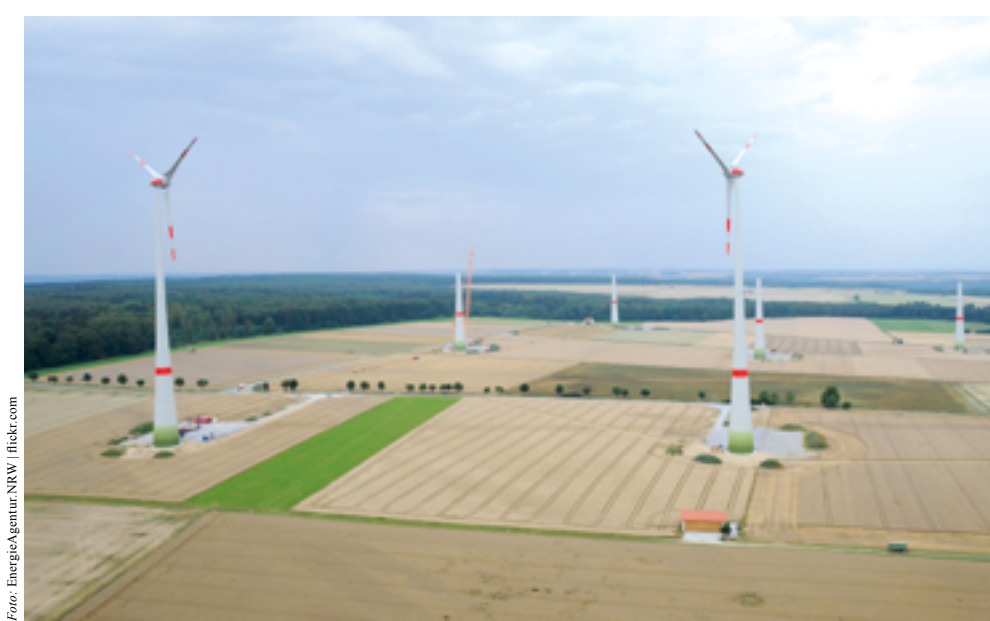
Baustelle Windpark: Auch hier wird fruchtbarer Boden aufgerissen, die Gruben werden achtlos zugeschüttet.
